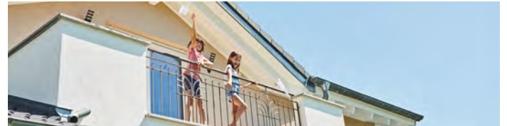
Draußen Sonne, drinnen angenehm kühl: Mit einem gut gedämmten Dach geht das auch ohne energieintensive Klimatisierung. Foto: DJD/puren
