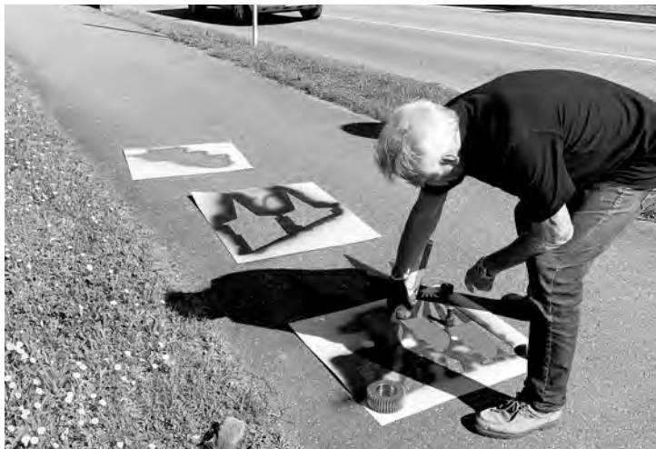
Mehrfarbig: Volker Kirst bei der Arbeit an den neuen Bodenmarkierungen vor der Unterführung an der Rastatter Straße.
