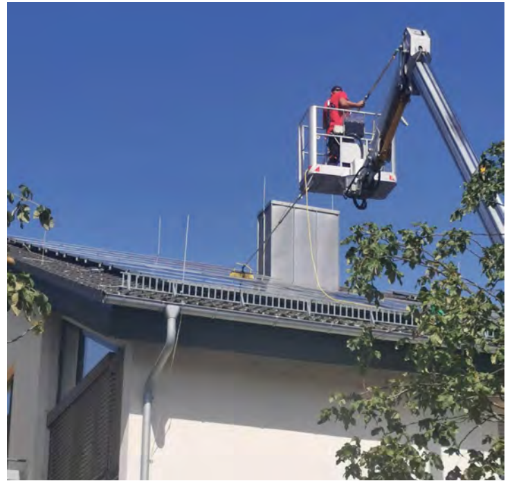
Reinigung über den Hubsteiger
