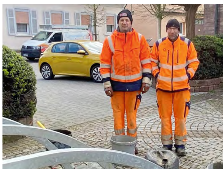
Cszaba Hagen und Peter Waschetzko bei der Montage des Fahrradständers vor dem Gemeindehaus „Alte Schule“
