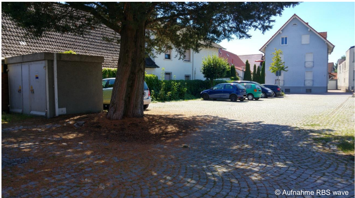
Abbildung 3-2: Parkplätze und Ortsnetzstation am Gemeindehaus Alte Schule in Ötigheim
