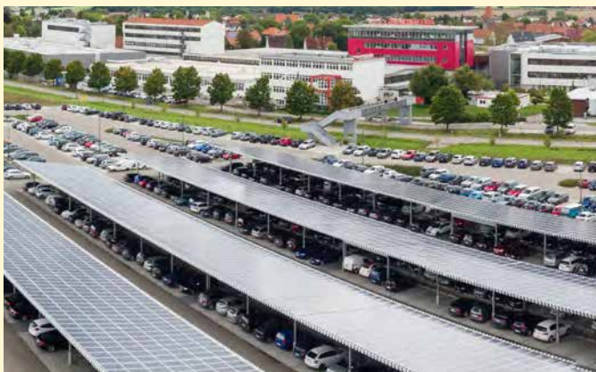
Photovoltaik-Parkplatz des Maschinenbauunternehmens Bausch+Ströbel in Ilshofen
