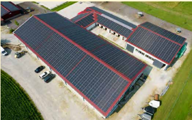
Werden Dächer bereits bei der Planung für die Solarnutzung optimiert, lassen sich große Flächen nutzen: Reiterhof in Gensenweiler mit nahezu vollständiger solarer Dachnutzung.
