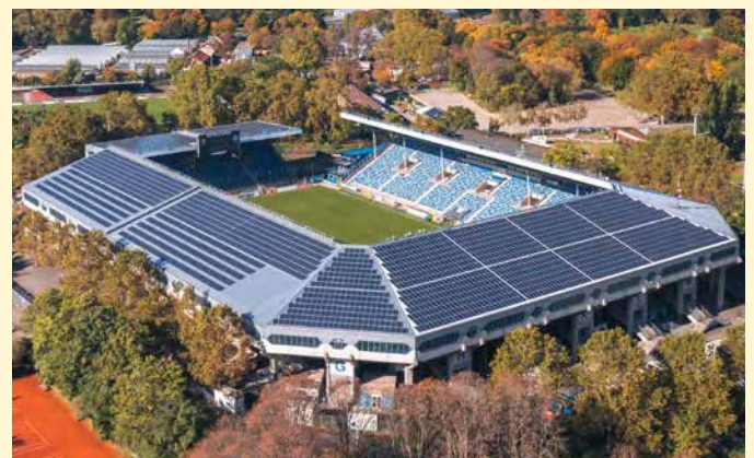
Neu gebaute Sportstätten und Vereinsgebäude fallen als Nicht- wohngebäude unter die Photovol- taik-Pflicht. Die große Solaranlage auf den Tribünen des Carl-Benz- Stadions in Mannheim ist seit dem Jahr 2002 in Betrieb.
