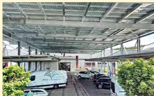
Solardach eines Waschparks in Tübingen
