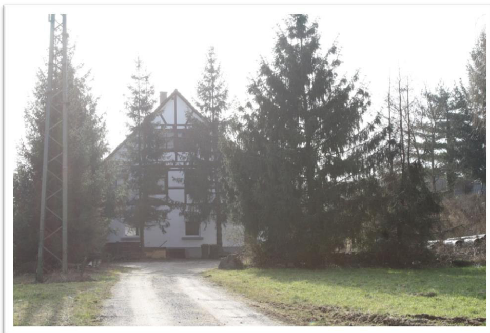
Abbildung 50: Wohn- und Lagergebäude Bahnhofstr. 1
